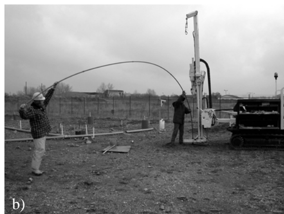
Abb. 4: a) Gazeummantelte Perforierung am Ende der PVC-U Rohre, b) Einbau der Gasinjektionslanzen am Testfeld mit Geoprobe-Technologie.
